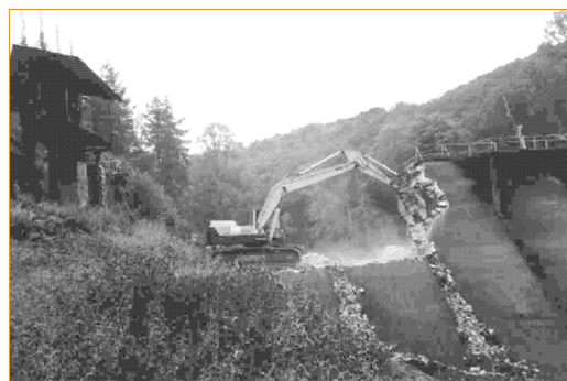
▲ Photo 7 – Démolition du barrage (Étape 1).
