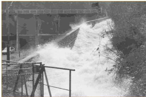
◀ Photo 2 – Un évacuateur de crue sous dimensionné (crue du 25 janvier 1995).
