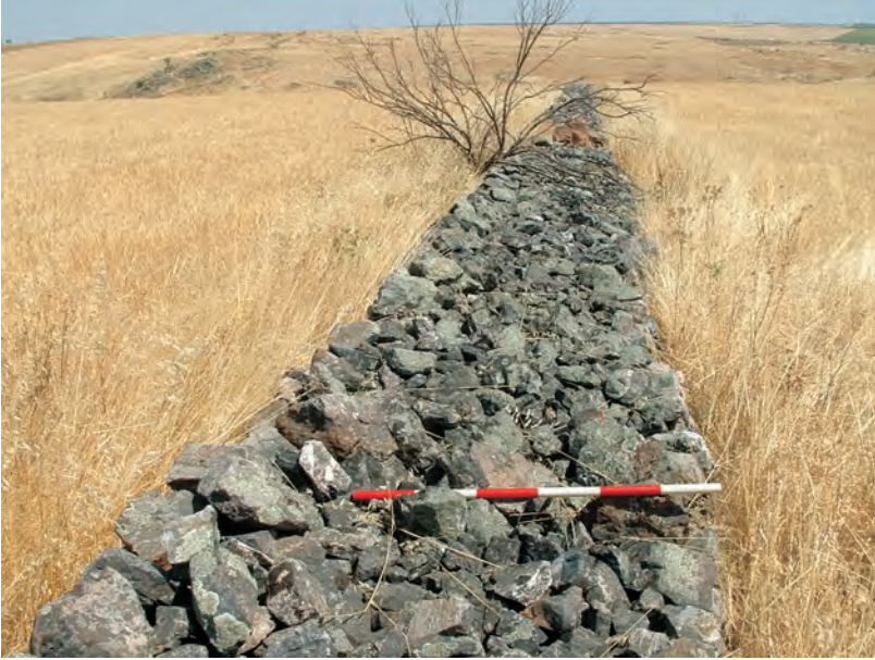
Fig. 3. – Détail du muraillement de la grande enceinte (côté est).
