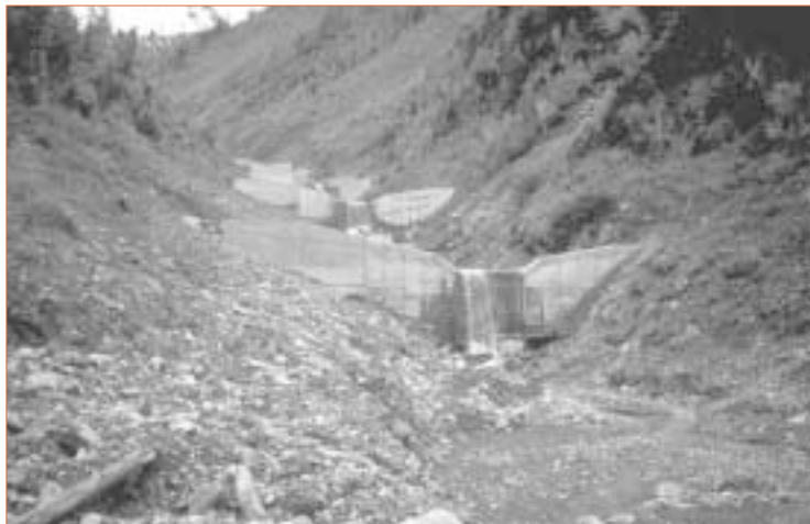
▲ Photo 1. – Seuil de correction torrentielle, torrent Saint-Antoine, Savoie.
