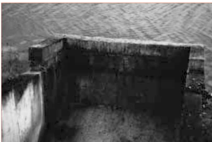
Photo 8. – Barrage de Urdens. Rehausse du seuil déversant par deux rangées de parpaings. ▼
