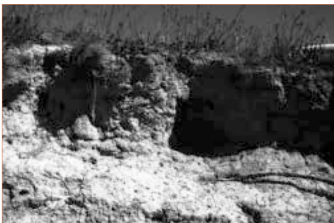
▲ Photo 2. – Barrage de Castillon-Debats. Forte dégradation du talus amont par les vagues.
