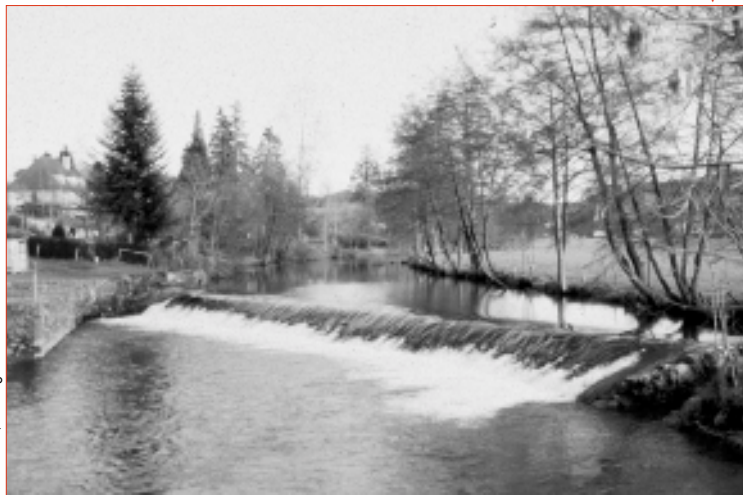
Photo 1. – Seuil à implantation oblique sur la rivière Cère, en conditions hivernales de débit.
