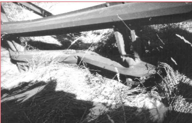
Photo 3. – Planches de bois cassées sur une barrière de neige (photo Y. Queffélec, Cemagref).
