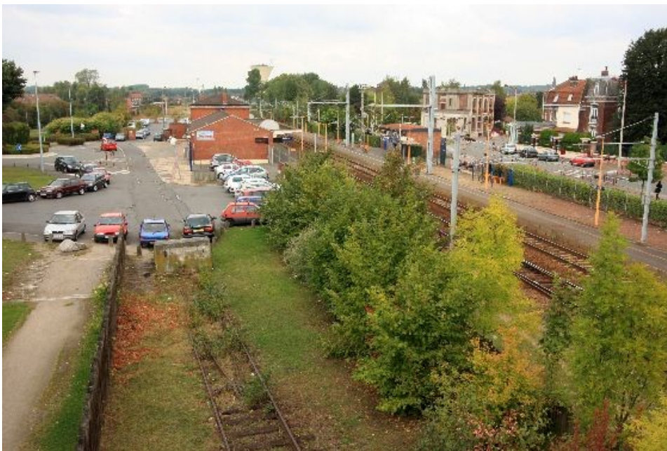
Figure 21: Libercourt une réalisation inaboutie
