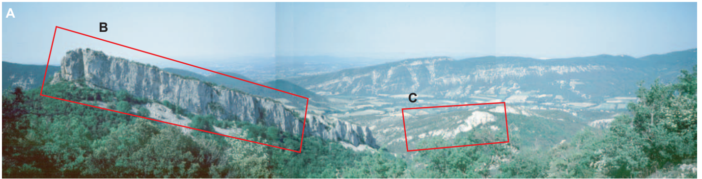
A - Vue générale. A droite (B), la falaise représente une coupe naturelle longitudinale dans le chenal. A l'arrière-plan (C), on a une coupe transversale dans la partie amont du chenal.
