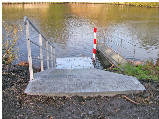
Figure 2 : rampe dédiée à la mise à l’eau de l’aDcp sur support radiocommandé (photo DIREN NPC)
