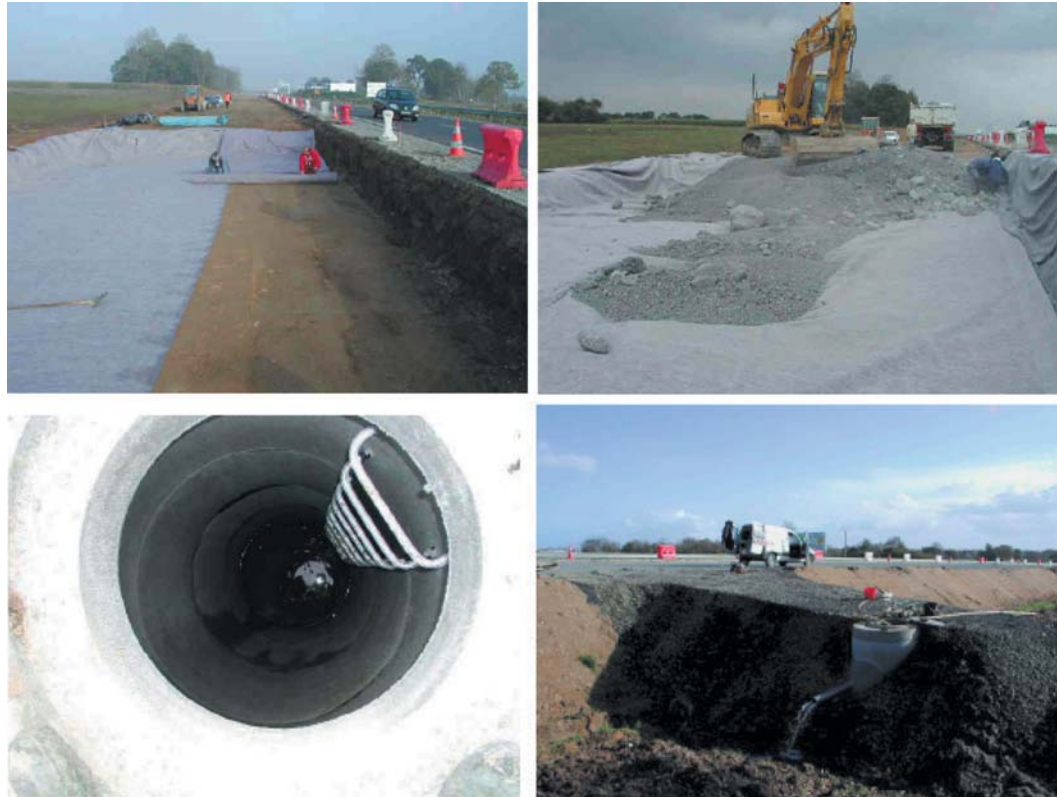
figure 8 Réalisation de la chaussée instrumentée RD767 (couche de forme MIOM).
