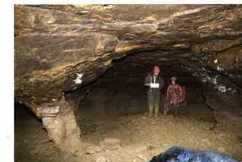
Un axe de circulation conduisant d'un chantier à un puits d'aération. Cliché F. Tereygeol
