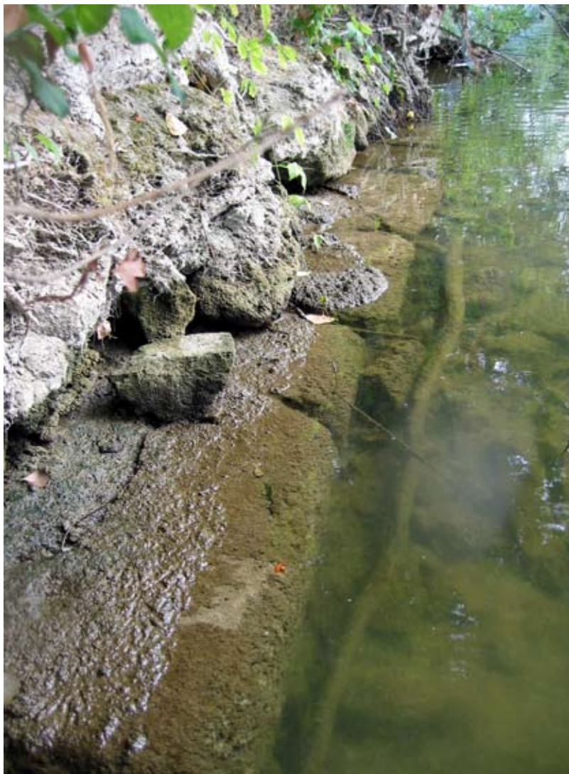
2. Des alignements de gros blocs taillés, repérés en plusieurs endroits sur la rive gauche du Doubs, matérialisent les vestiges de probables renforcements de berge.
