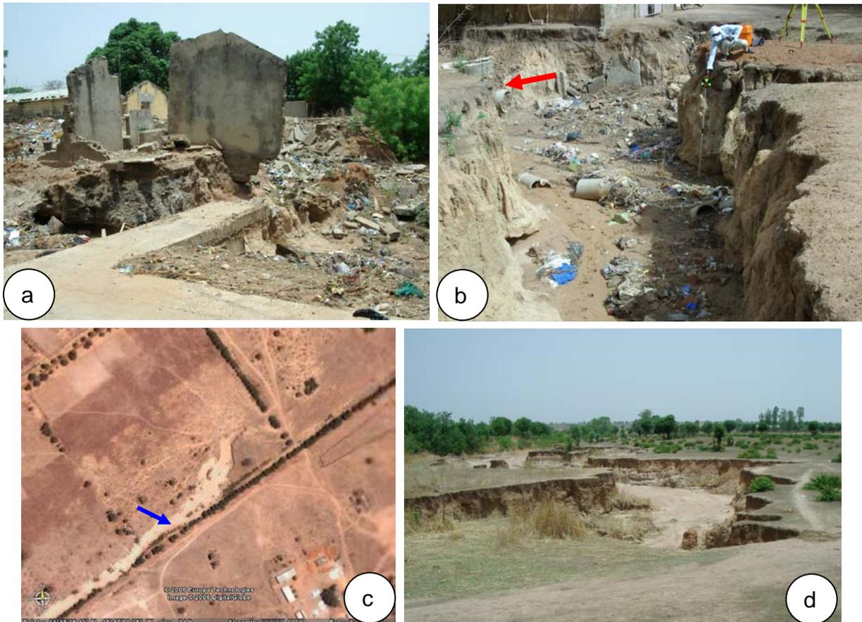
**Figure 3 :** Exemples de dégâts causés à Nioro par l'érosion hydrique et le ravinement associé. a : maison effondrée ; b : tuyau de canalisation sectionnée (flèche rouge) ; c et d : perte de terres agricoles (c : vue du ravin de l'ISRA (flèche bleue) sur image Google Earth ; d : photo de terrain)
