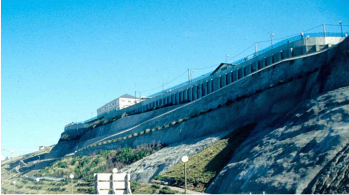
Figure 2 : la falaise de Biarritz entièrement reprofilée (photographie d'A. Miossec).
