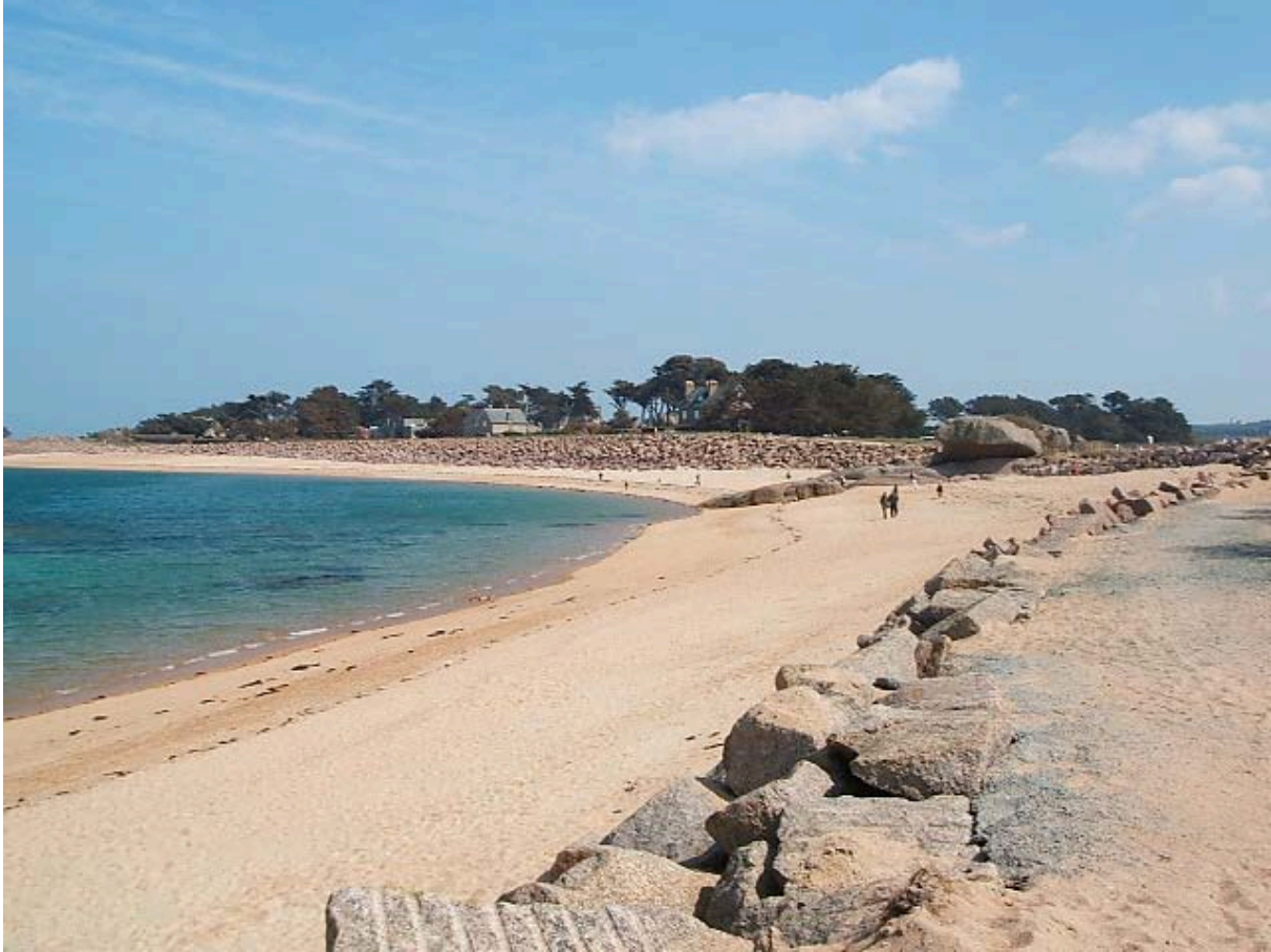
Figure 5 : enrochements à Trégastel (22)
