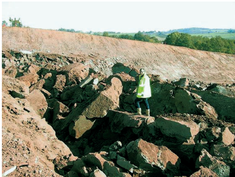
figure 6 Extraction des pélites par minage.
