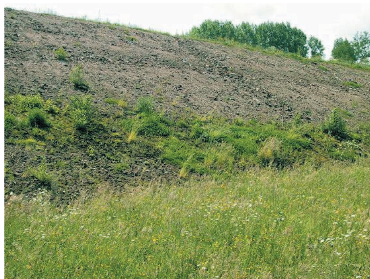
figure 9 Zone humide en base du remblai (15 mai 2003).
