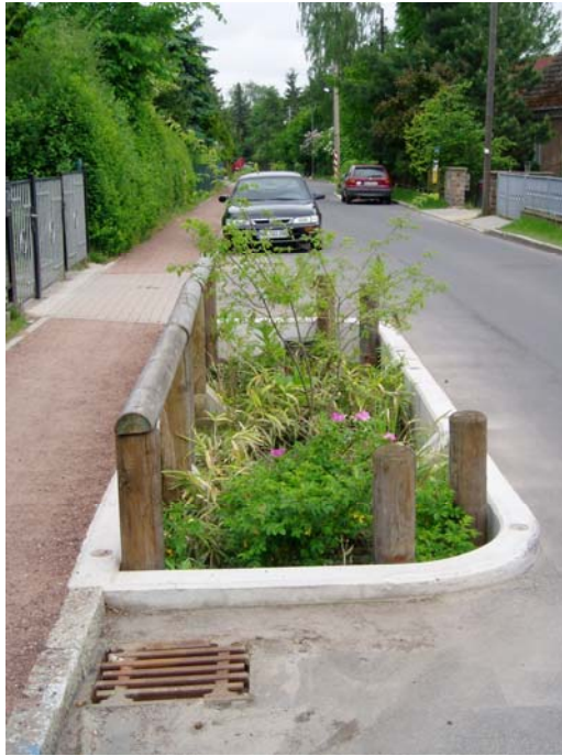
Figure 8. Exemple de solution mixte de gestion à la source des eaux pluviales urbaines associant un ralentisseur de circulation routière, un bassin d'infiltration et un massif floral (Hoppegarten, banlieue est de Berlin, Sieker mbH) (crédit photo : D. Thévenot).
