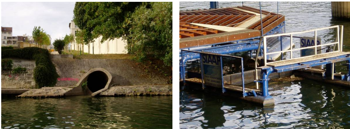
Figure 1. Ouvrages destinés à évacuer en rivière les eaux usées qui ne peuvent être stockées ou acheminées vers la station d'épuration (déversoir d'orage de Clichy en Seine) et à minimiser l'impact de ces rejets (barrages flottants du SIAAP à Clichy) (crédit photo : D. Thévenot).
