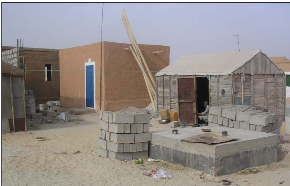
Photo 2 Exemple de module qui comporte une chambre, latrine (fosse au premier plan) et clôture. Les anciennes cabanes du bidonville constituent toujours un habitat d'appoint. (Cliché de l'auteur, 01/2004) Example of module : room, septic tank and fence. In front of it, the slum's cabin, still here.
