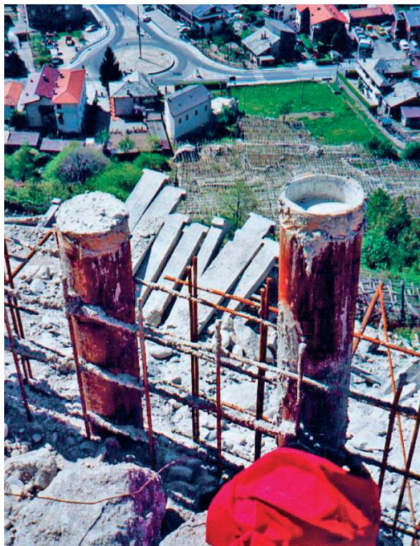
Figure 3.39 - Rondias : un glissement encore actif (avril 2003). Au second plan, la disposition anarchique des plaques de béton prouve que le mouvement a rejoué depuis le début des travaux.
