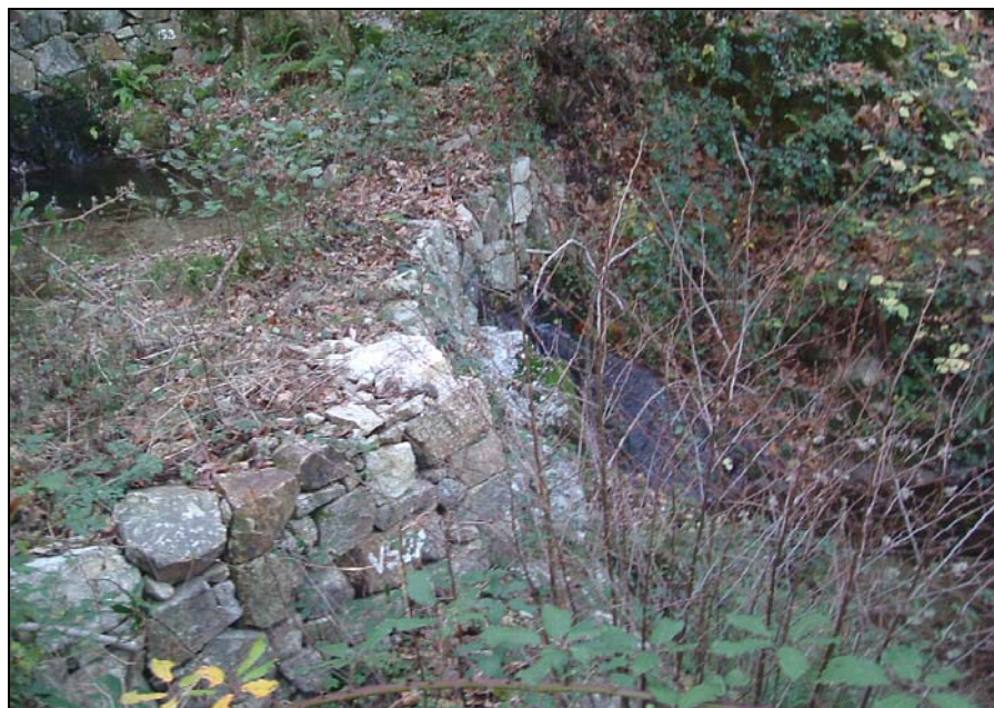
Photo 5 - Petits tancats sur le bassin versant de la Bastide : l'eau circule dans la masse des sédiments et sourd à la base du tancat aval
