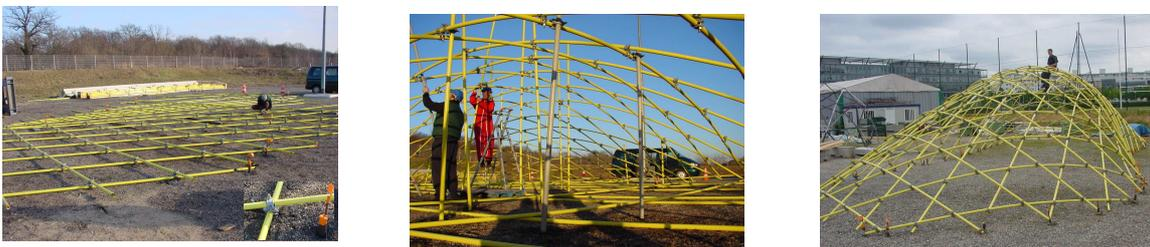
Fig. 4. Phases de construction du premier prototype de Grid Shell en matériaux composites.
