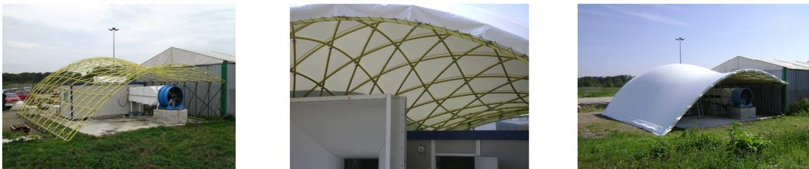
Fig. 5. Second prototype de Grid Shells en matériaux composites avec couverture.
