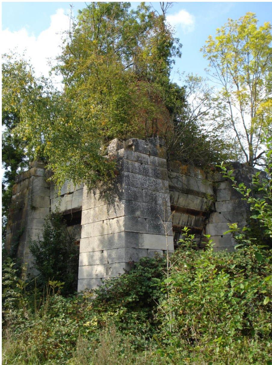
Fig. 3 - Les beaux restes du haut fourneau de Ménaucourt Photo de l'auteur (septembre 2007)
