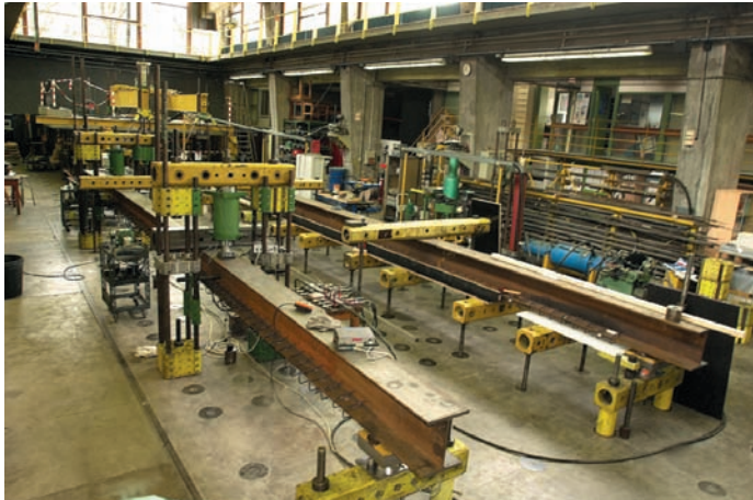
figure 20 Préflexion du profilé métallique (étape b ) et mise en place du coffrage.
