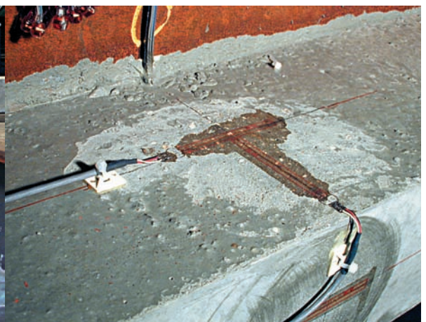
figure 25 Jauges de déformation collées sur les surfaces du talon en béton pour suivre l'évolution des déformations.
