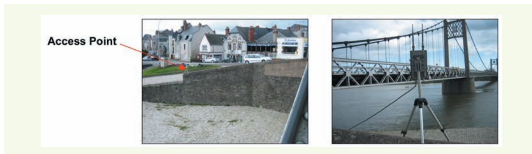
figure 11 Access Point situé à 20 m en aval du pont sur la rive droite.
