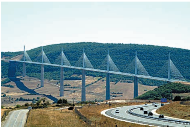
Ouvrages instrumentés a : viaduc de Millau b : pont de Stonecutters
