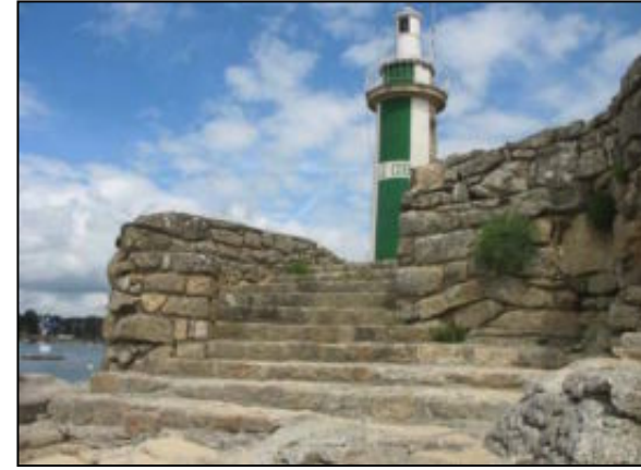
Escalier maçonné à L'île Tudy
