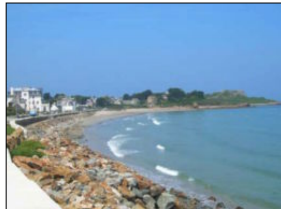
Mur et enrochement à Plougasnou
