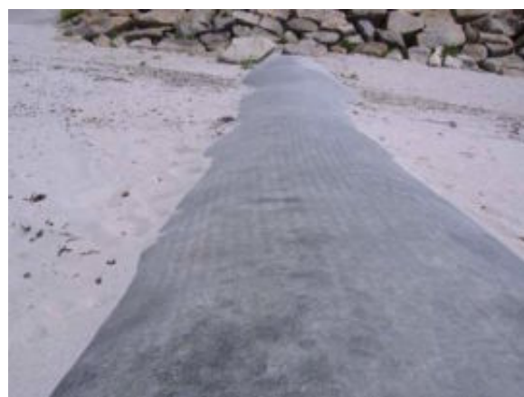
Epi de géotextile au Guilvinec
