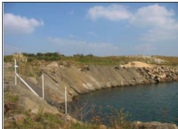
Ouvrage de protection en béton dans le port de Brest
