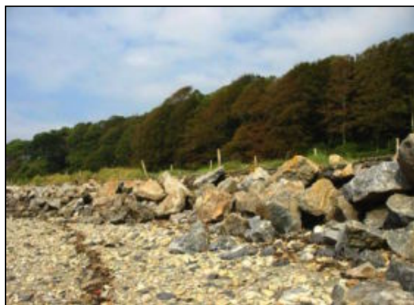
Enrochement non cohérent à Plouezoch
