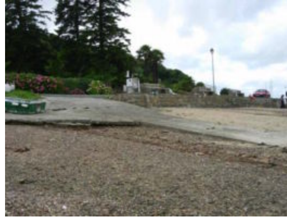
Cale en ciment à Landévennec
