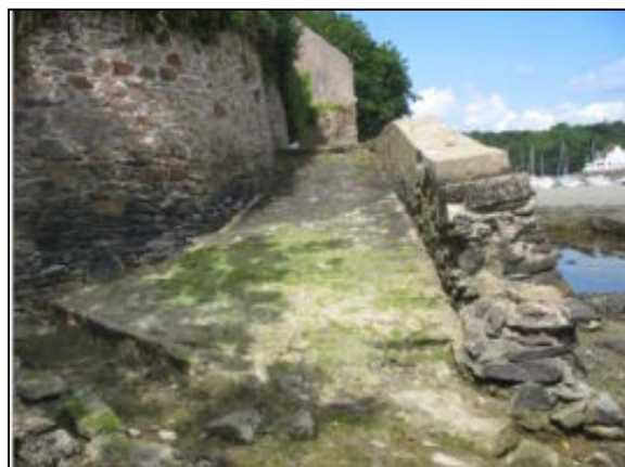
Cale maçonnée sur l'Aven
