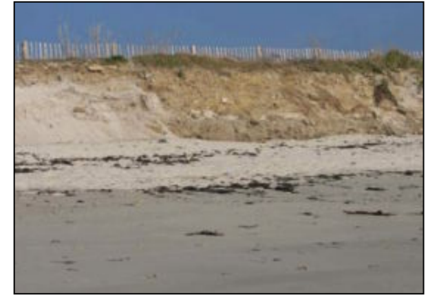
Remblais de tout-venant pour fermer d'anciennes brèches dans le cordon du Cosquer (Loctudy)
