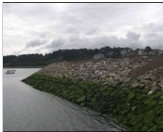
Enrochement cohérent à l'Aberwrac'h
