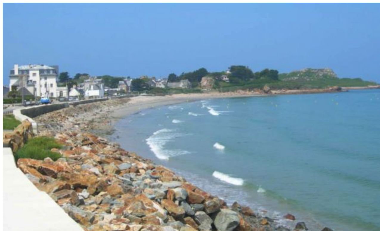
Enrochement cohérent à Plougasnou
