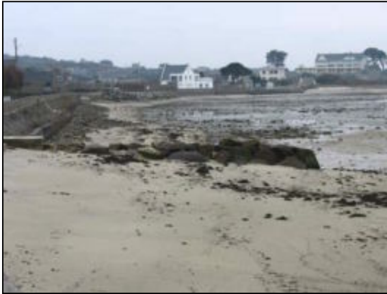
Le Tevenn à Roscoff : ouvrage transversal en enrochements
