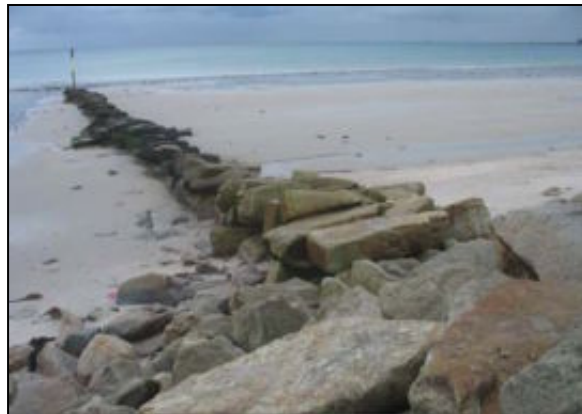
Epi en enrochements au Téven (Île-Tudy)
