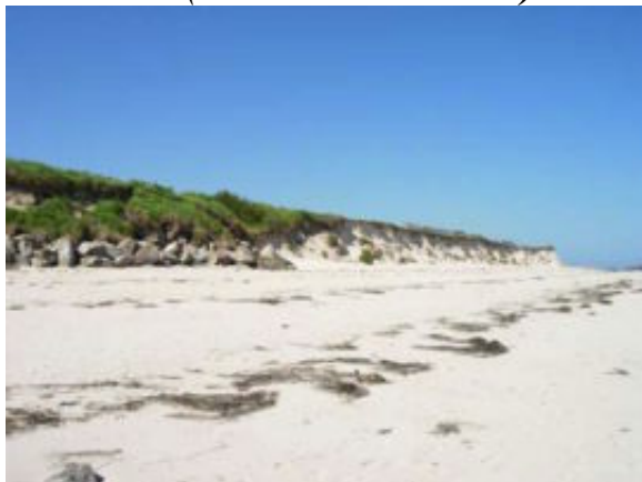
Ar3 – Dune (enrochement à Cléder)
