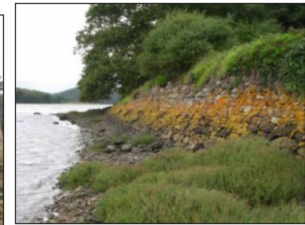
Perré de pierre sèche à Landévennec
