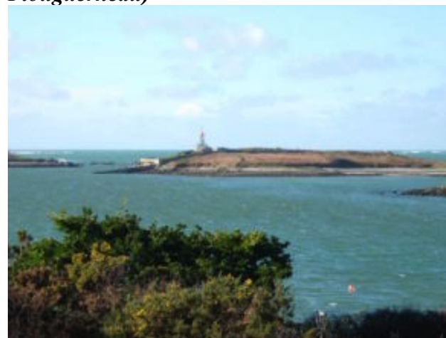
Ar31 – Signalisation maritime (Ile wrac'h à Plouguerneau)
