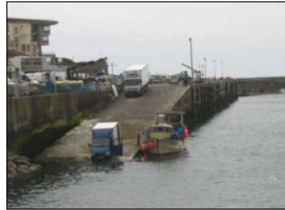
Cale et quais en béton armé au Conquet
