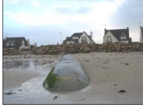
Epi en géotextile au Guilvinec
