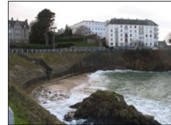
Mur de soutènement de route, Douarnenez
