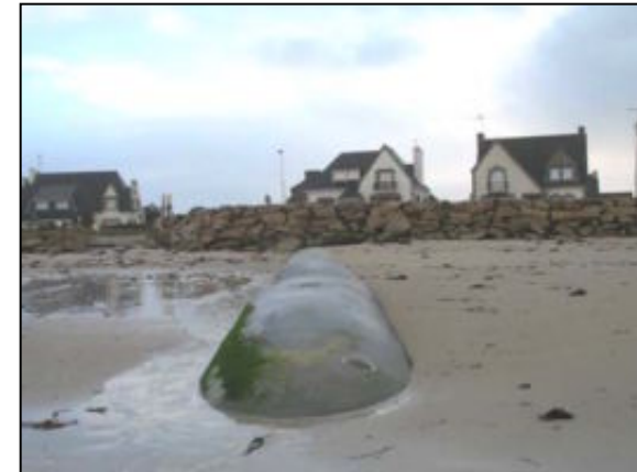
Epi en géotextile au Guilvinec
