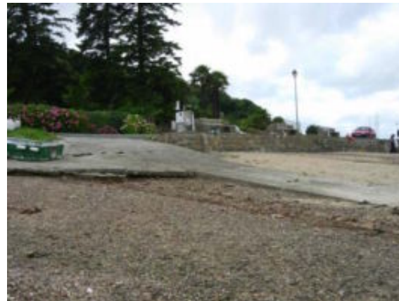
Cale en ciment à Landévennec
