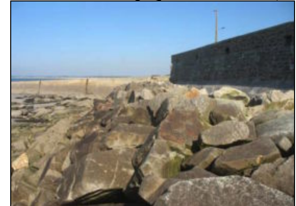
Ar10 – Autre ouvrage (port de Moustierlin)
