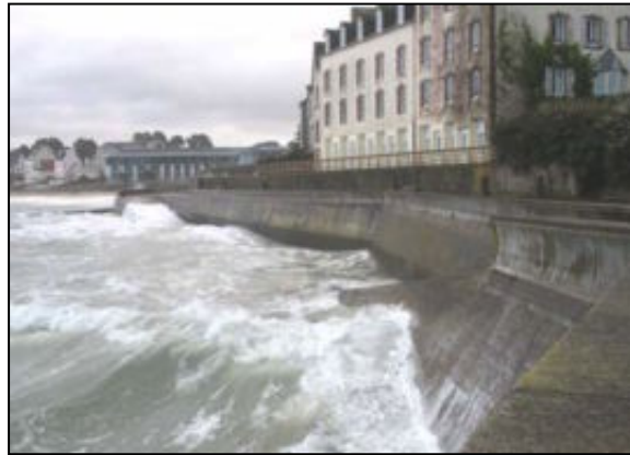
Mur de défense côtière en béton armé à Tréboul
