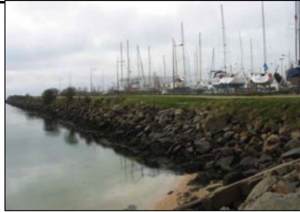
Enrochements du pourtour du polder à l'ouest du port de plaisance du Moulin-Blanc à Brest
