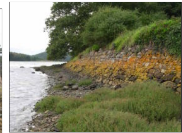
Perré de pierre sèche à Landévennec
