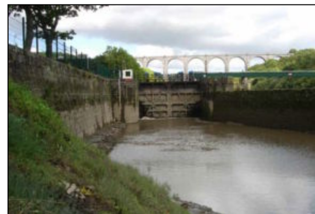
Ecluse du Guilly-Glaz en aval de Chateaulin
