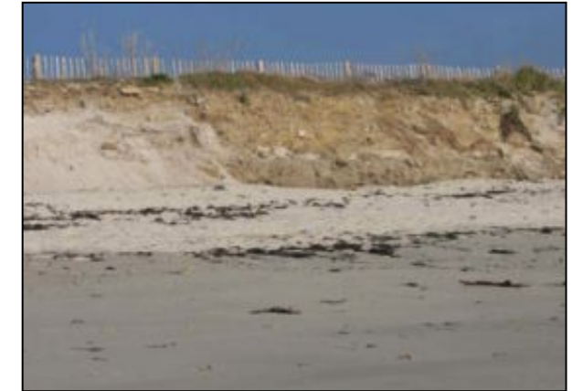
Remblais de tout-venant pour fermer d'anciennes brèches dans le cordon du Cosquer (Loctudy)
