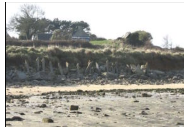
Protection du trait de côte en morceaux de tétrapodes
