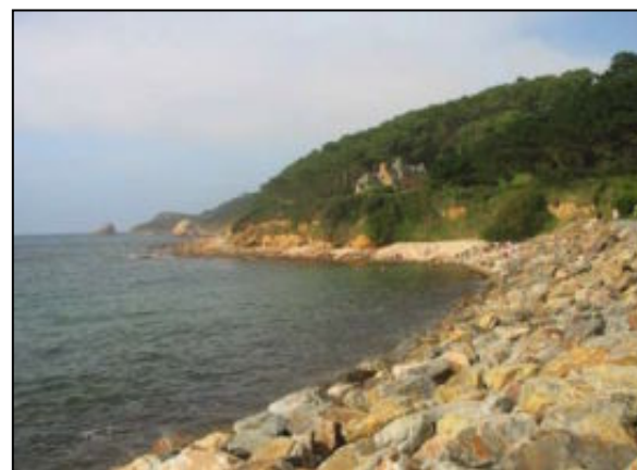
Enrochement à Trégastel
