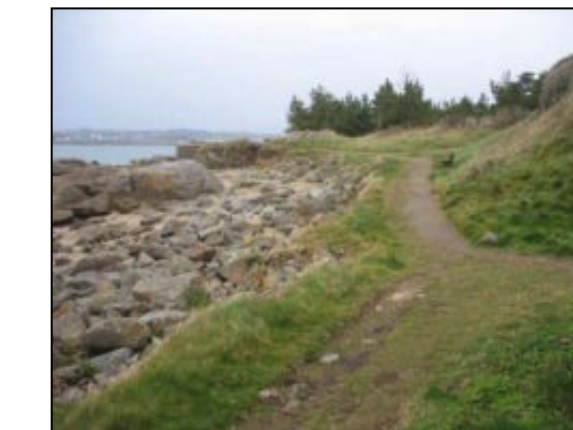
Cordon d'énrochement à la pointe du Cabellou
