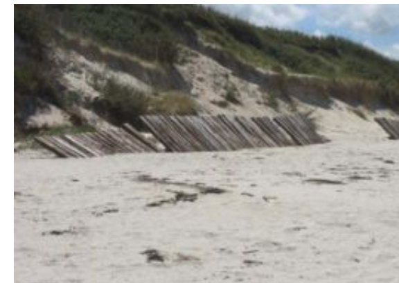
Corn ar Gazel : protection en traverses de chemin de fer
