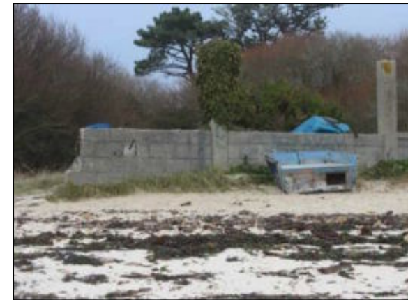
Mur de parpaings à Kermingham (Lanriec)
