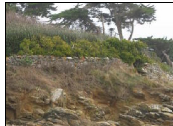
Muret de pierre sèche au Cabellou
