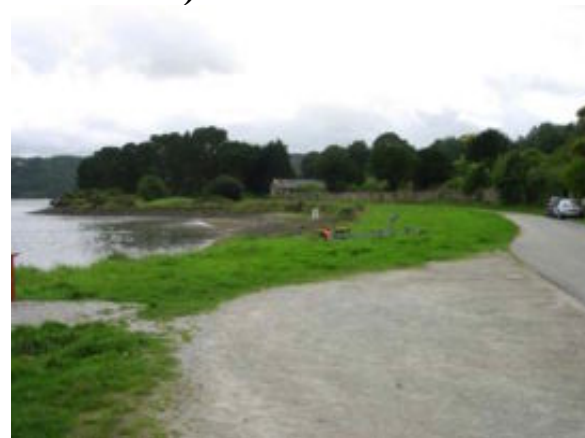
Ar18 – Remblais (ancienne décharge de Landévennec)
