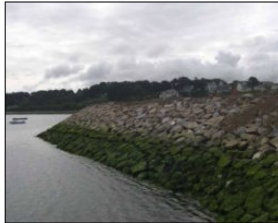
Enrochement cohérent à l'Aberwrac'h
