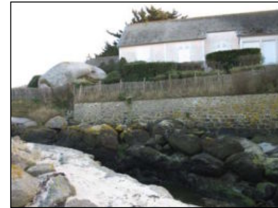
Mur en maçonnerie, La Digue (Kerlouan)
