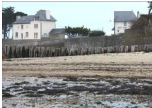
Epi en traverses de chemin de fer à Carantec
