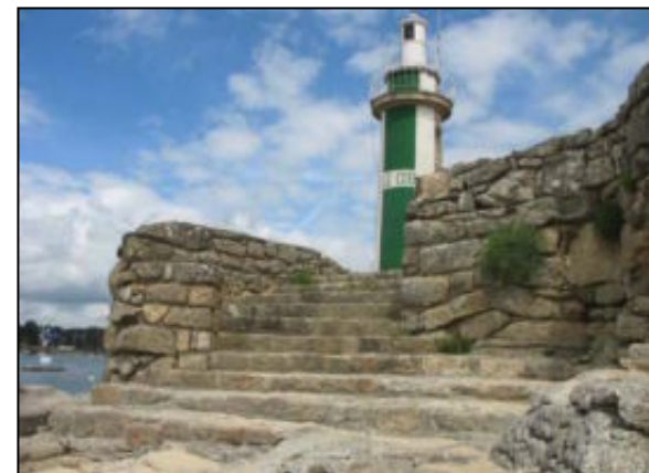
Escalier maçonné à L'île Tudy
