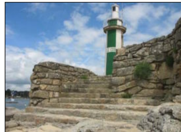
Escalier maçonné à L'île Tudy
