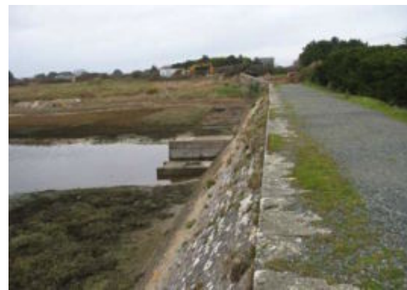
Digue pour la poldérisation sur le Steir à Loctudy
