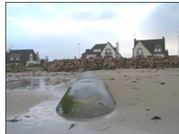
Epi en géotextile au Guilvinec
