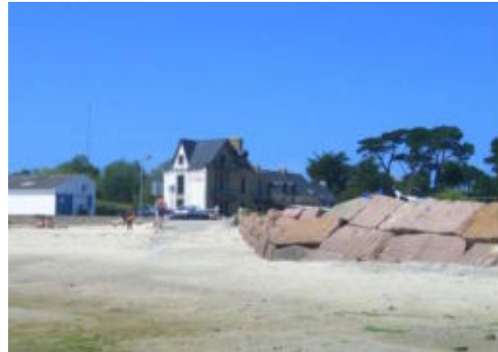
Enrochement de protection du port de Saint-Pol-de-Léon
