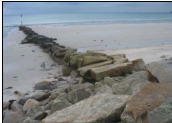
Epi en enrochements au Téven (Île-Tudy)
