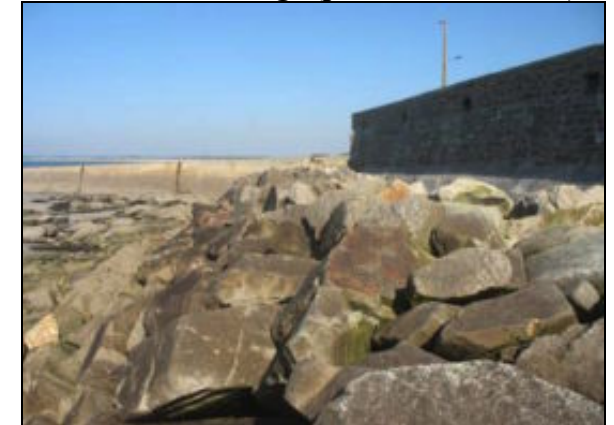
Ar10 – Autre ouvrage (port de Moustierlin)
