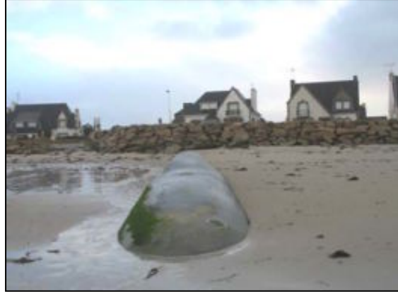
Epi en géotextile au Guilvinec
