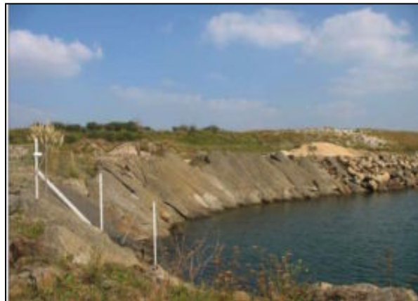
Ouvrage de protection en béton dans le port de Brest
