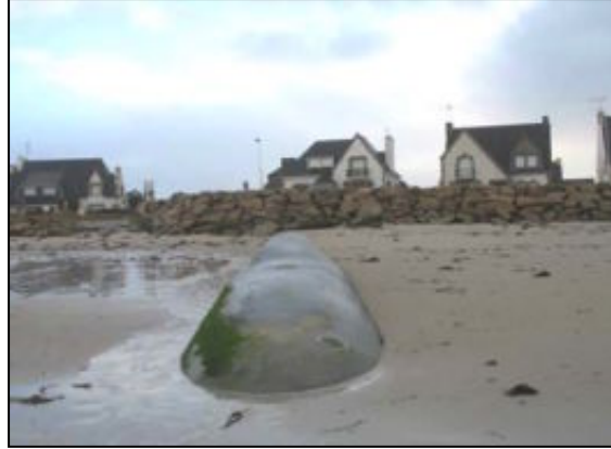
Epi en géotextile au Guilvinec
