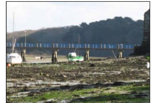
Passerelle pour piétons dans la ria du Conquet
