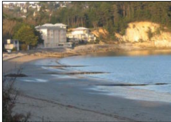
Batterie d'épis en géotextile dans l'anse de Morgat
