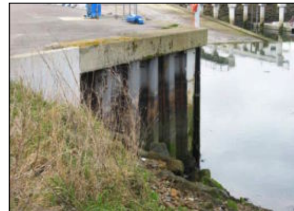
Extrémité de quai en palplanches au Moulin-Blanc
