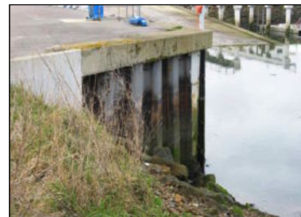
Extrémité de quai en palplanches au Moulin-Blanc
