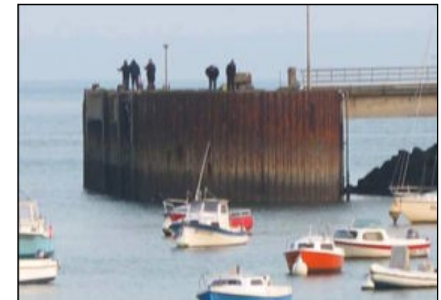
Ouvrage d'accostage en palplanches (Sainte-Anne-du-Portzic)
