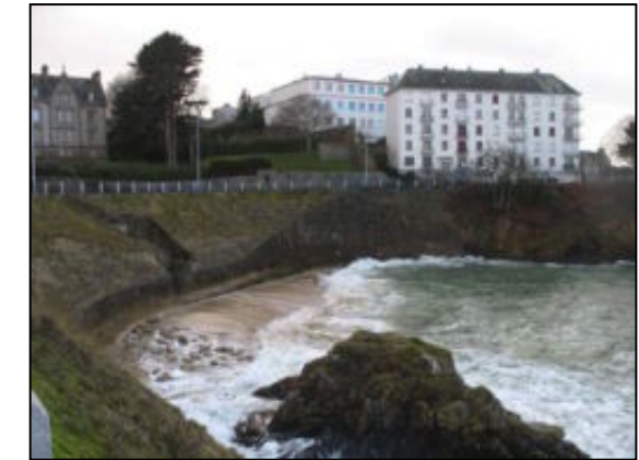
Mur de soutènement de route, Douarnenez
