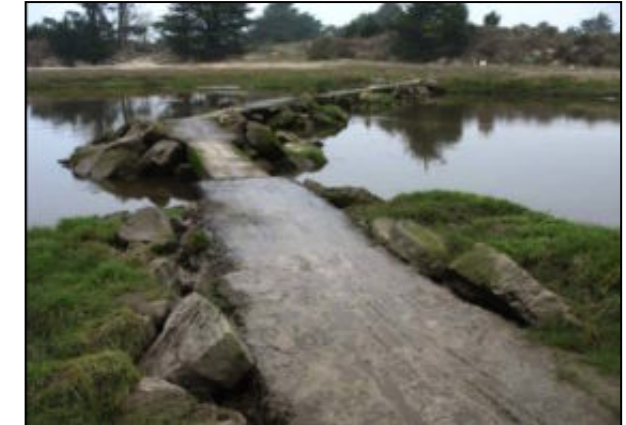
Le pont à marée sur l'Horn (Santec)
