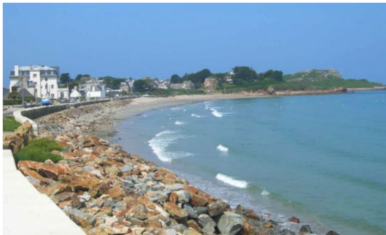
Enrochement cohérent à Plougasnou
