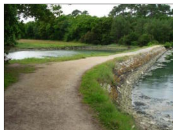
Digue dans la rivière de Pont l'Abbé
