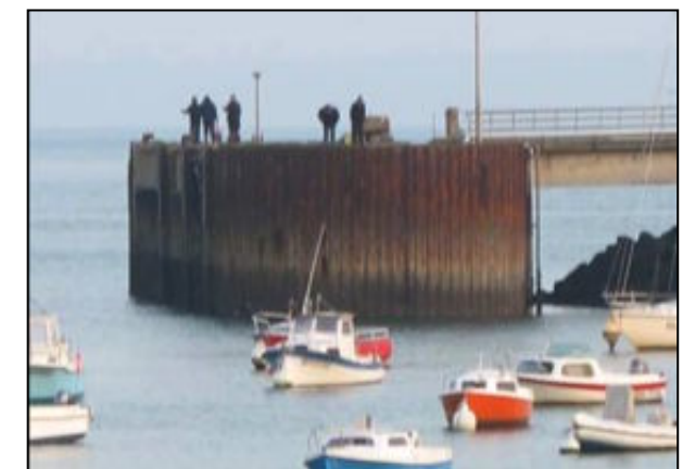
Ouvrage d'accostage en palplanches (Sainte-Anne-du-Portzic)
