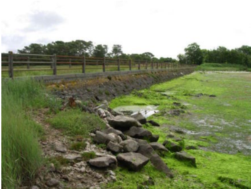
Pont-digue dans la rivière de Pont l'Abbé
