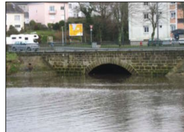
Pont routier au fond de la ria de Douarnenez
