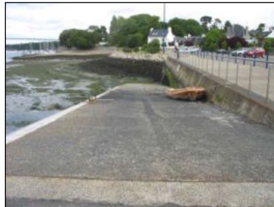
Cale dans le port de Bénodet
