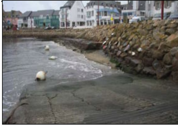
Cordons d'enrochements maçonnés dans le port de Lesconil
