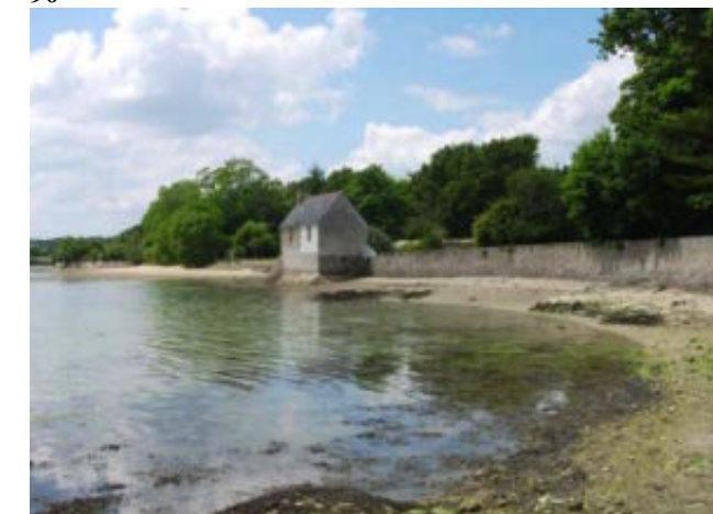
Bâtiment et mur de propriété à La Forêt-Fouesnant
