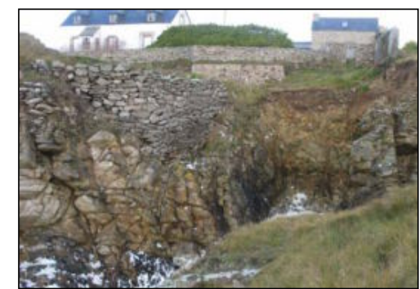
Mur en pierres sèches, Porstarz, Cap-Sizun
