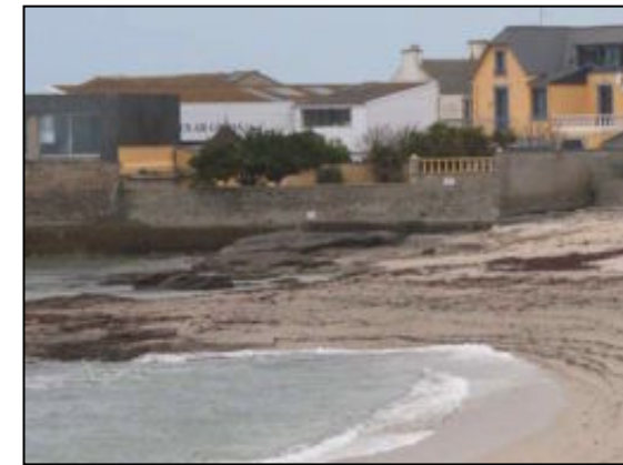
Murs de protection, pointe de Men-Meur (Léchiagat)
