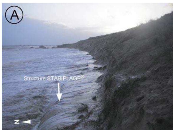
Photo 3A. Submersion du Stabiplage® durant la tempête du 10 mars 2008 au matin
