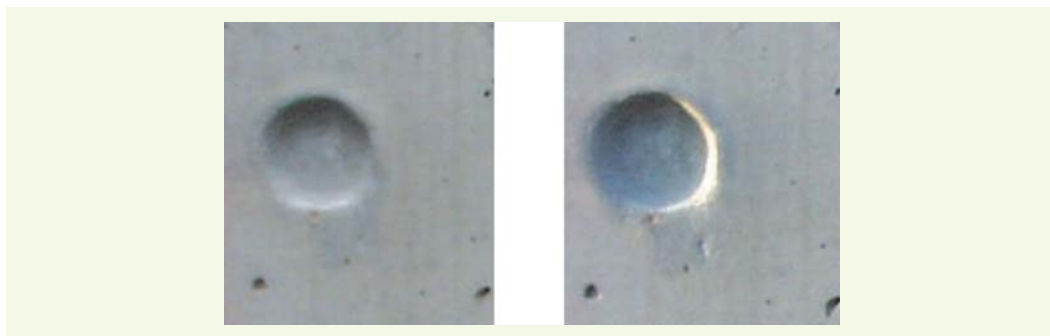
figure 8 Trou de coffrage photographié à 15 h puis à 21 h au mois de juin.
