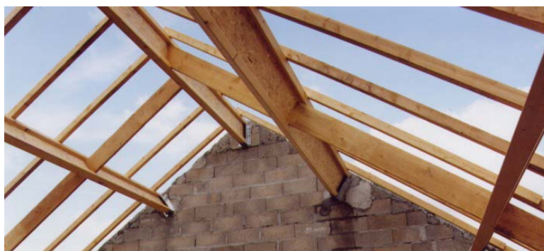
PHOTO. 2 - Bâtiment de l'OPHLM de Chartres en construction
