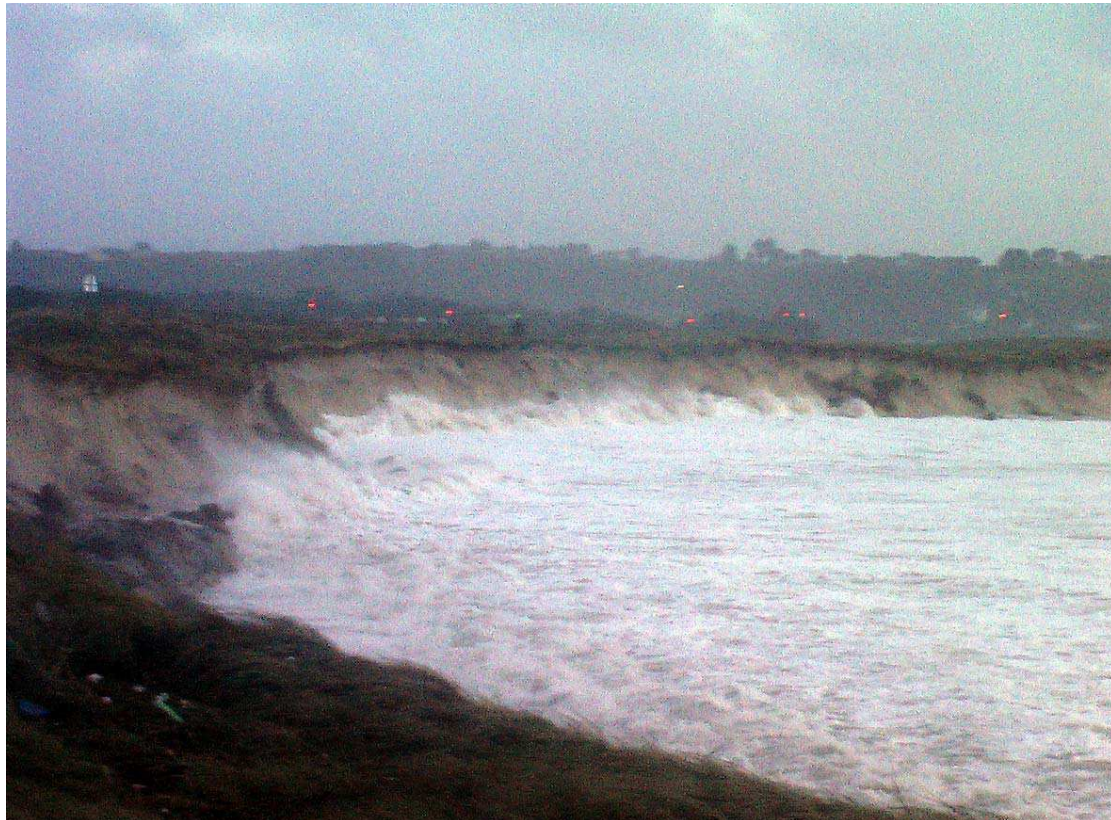
Photo 2 – Enrochement en pied de dune (à l'est de la radiale 01) submergé par le déferlement des vagues (10/03/2008 – 19h30)
