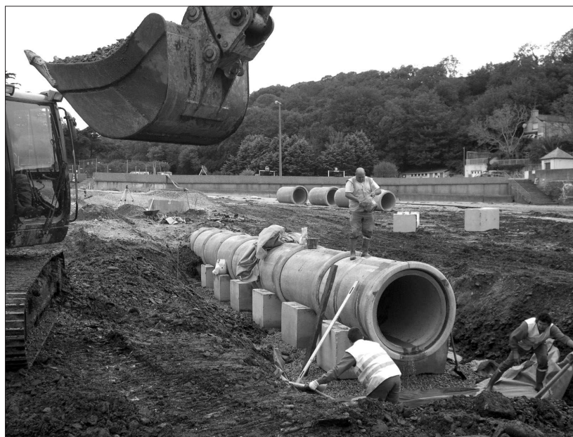
Photo 3 : Travaux d'allongement de la buse au débouché du ruisseau en septembre 2007
