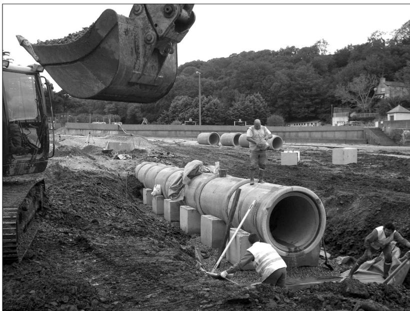
Dans le même esprit, le débouché des eaux pluviales situé au pied de l'accès oriental de la plage occasionnait un transport de sable vers le bas d'estran lors des fortes précipitations. Il a été raccordé au réseau de collecte existant sur le secteur.
