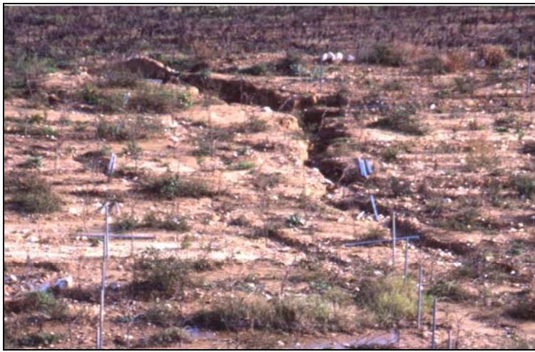
Photo 3 - Érosion linéaire sur pente forte.
