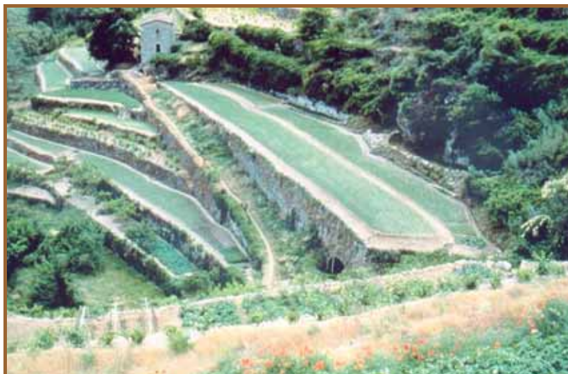
Photo 11 - Terrasses d'oignons doux à Saint-André-de-Majencoules (Gard). (cliché : M. SABATIER)
