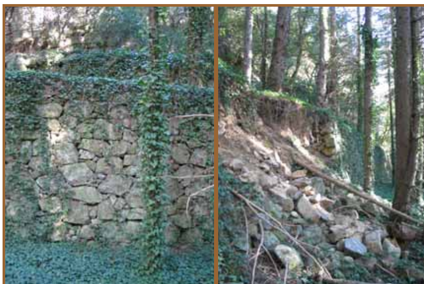
Photo 7 - Mur de terrasse en bon état près de Peyrolles (Gard). (cliché : J.M. CASTEX)
