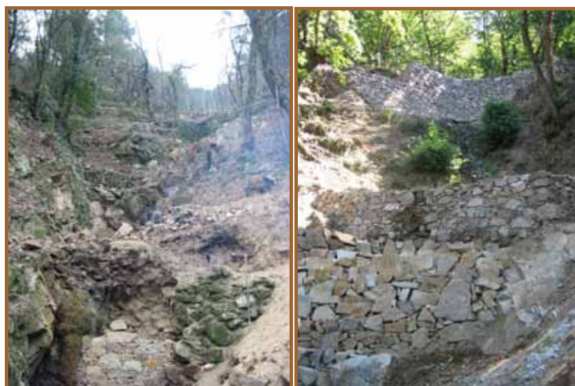
Photos 21 - Réhabilitations de tancats sur un affluent (V2) du ruisseau de Valescure : état des travaux en mars (à gauche) et en août (à droite) 2005. (clichés : G. ROQUES)
