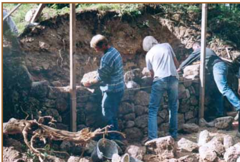
Photo 12 - Démonstration de montage d'un mur en pierre sèche. (cliché : D. LÉCUYER)
