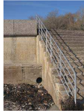
Figure 5 : le débouché des eaux pluviales à l'est de la plage
