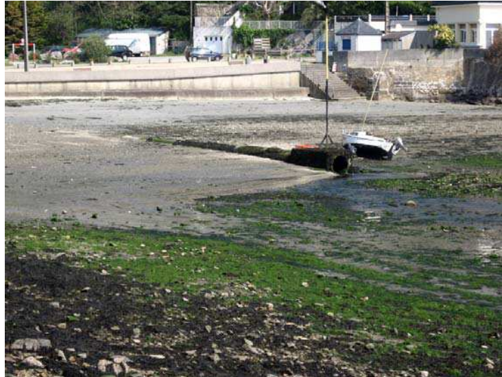
Figure 12 : Mai 2007, avant allongement de la buse, le sable du haut de plage est entraîné vers le bas de la zone intertidale par les eaux du ruisseau.
