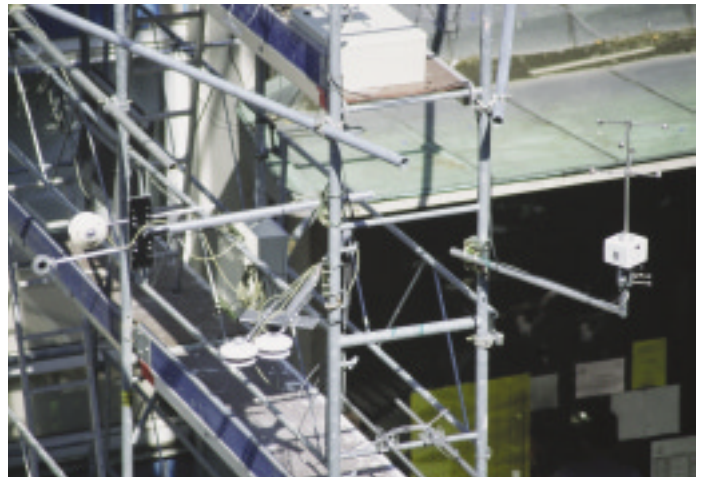
▲ Figure 2 : Appareils de mesures installés sur l'échafaudage de la rue de l'Argonne.
