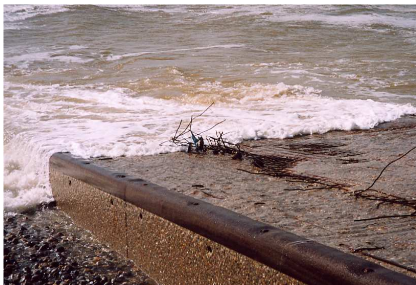
Document 5 : l'assaut des houles projetant les galets rend vulnérables les épis.
