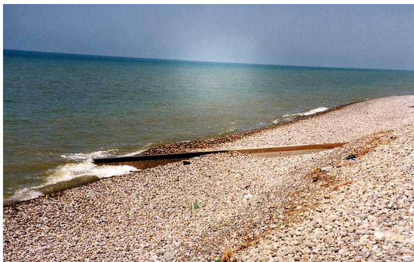
Document 4 : épis renforçant la digue des bas-champs au sud de Cayeux (Photo V. Bawedin, 2003)
