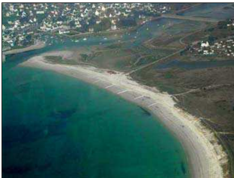
Photo 1 : Vue aérienne de la plage des Sables Blancs et des Stabiplate® (source : Espace Pur)
