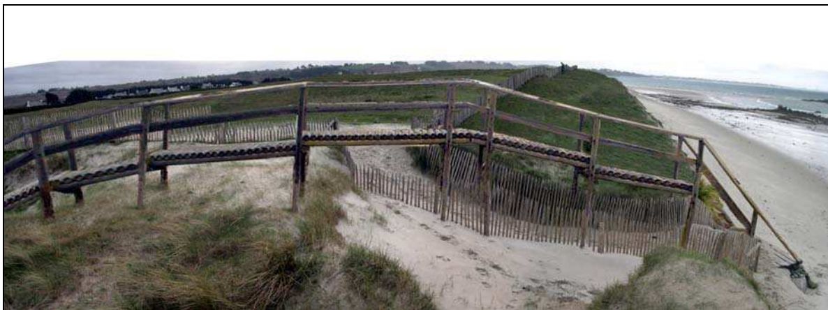
Photo 3 – Mise en situation à partir d'une simulation sur site
