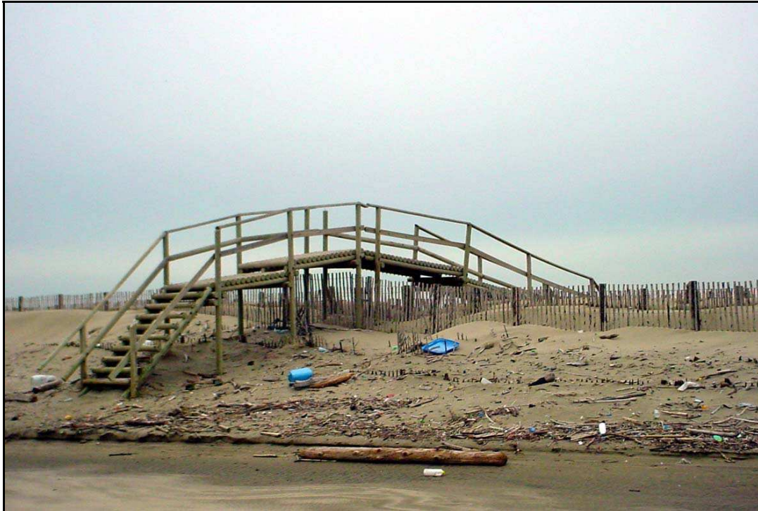
Photo 2 – Exemple de structure de type « passerelle en bois sur pilotis » afin de protéger le bourrelet dunaire du piétinement par les usagers (plage de Camargue - flèche de la Gracieuse, commune de Port-St-Louis du Rhône)
