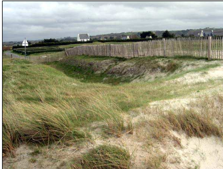
Photo 1 – Ancien chemin des goémoniers et plus récemment d'accès du camping municipal à la plage format un sillon entaillant la dune grise
