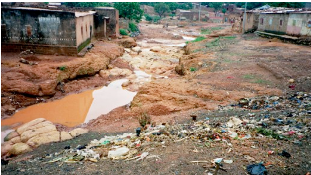
Tas d'ordures sur les berges du Houet (en amont du pont) au « village » de Tounouma, centre-ville de Bobo-Dioulasso (cliché Bouju)
