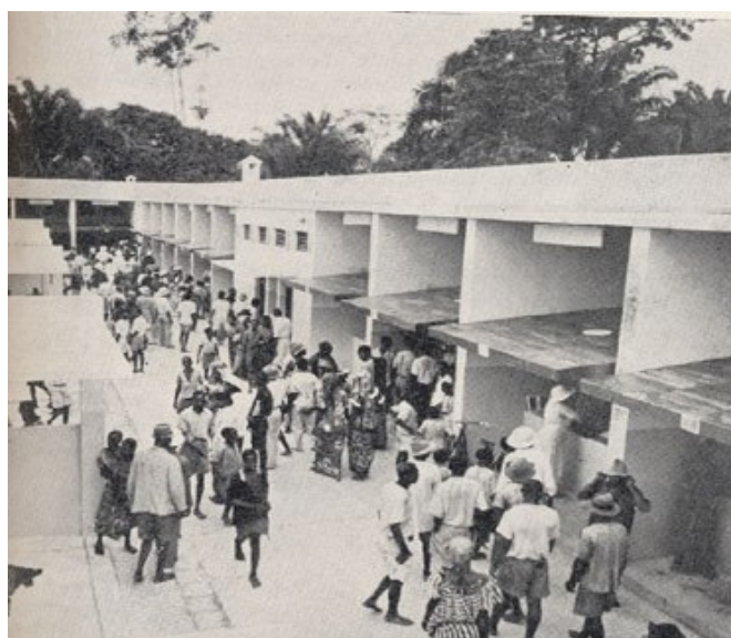
Le marché public de Léopoldville construit en 1943 (Source : CAPELLE, 1947 :47)
