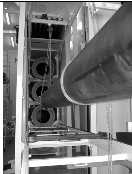
Figure 2 : mise en place d'un tube
