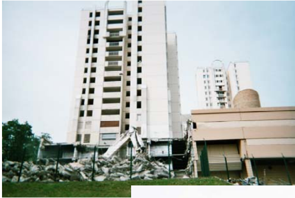
Destruction du centre commercial et des deux tours centrales. Les Tarterêts, juillet 2004.
