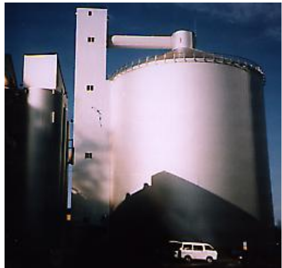
Fig. 12 : Grand silo de stockage de sucre.
