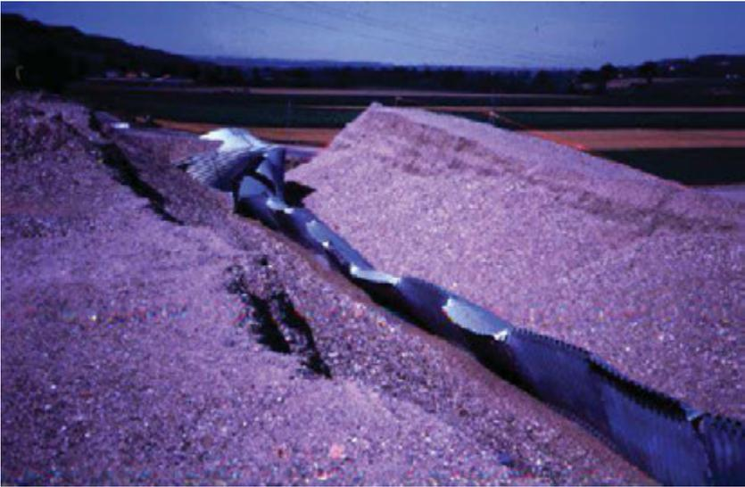
**Figure 10.** Buse métallique effondrée lors de sa construction sous une autoroute.
