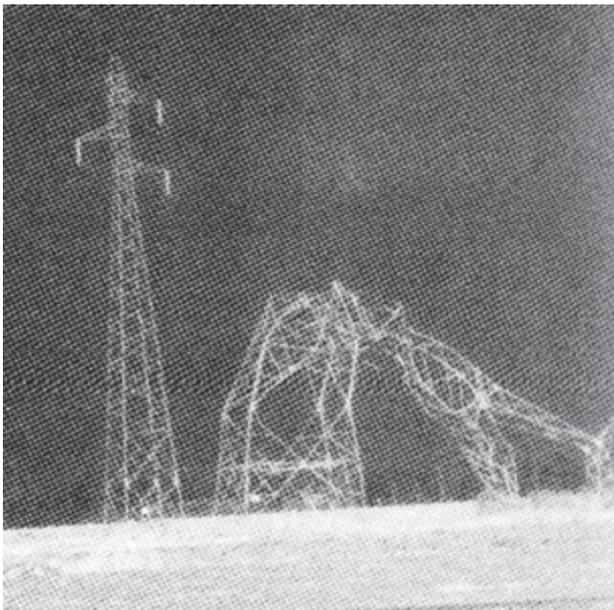
**Figure 18.** Pylône à haute tension en mal d'assise après la tempête du 25 décembre 1999.
