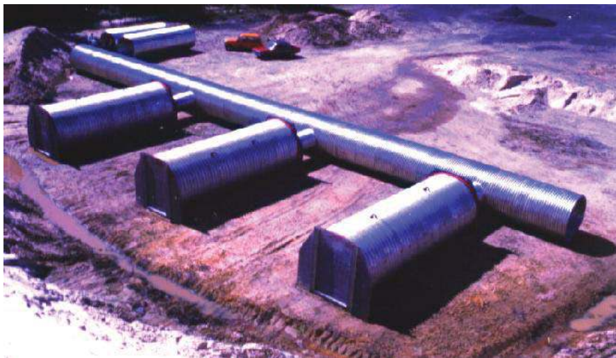
Figure 11. Expérimentation en vraie grandeur des buses métalliques sous fort recouvrement.
