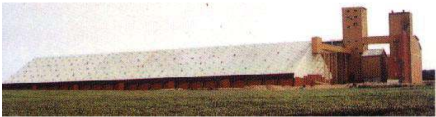
Figure 15. Complexe de stockage céréalier en silos métalliques de 150.000 tonnes.
