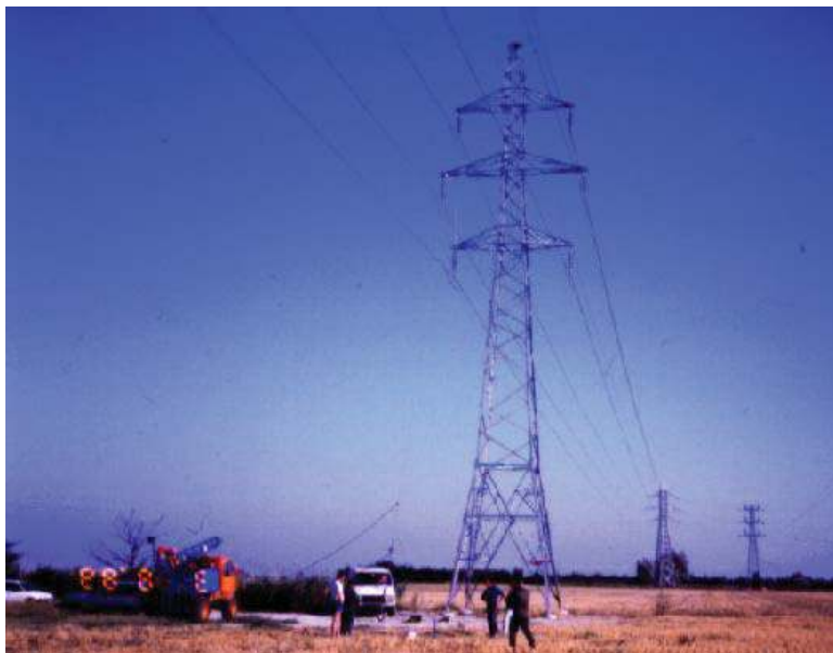
Figure 20. Test du lâcher sur les pylônes électriques.
