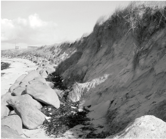
Figure 2 – Enrochement mis en place dans la section orientale du cordon dunaire aujourd'hui déconnecté du pied de dune par l'érosion marine qui le contourne.
