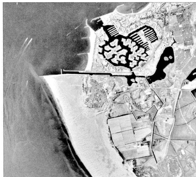
Photo 5 – Batterie d'épis sur le littoral de la Petite Camargue (cliché du Service Maritime et de Navigation du Languedoc-Roussillon, 1998).
